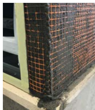
Applicazione rete di armatura ed antifessurazione
