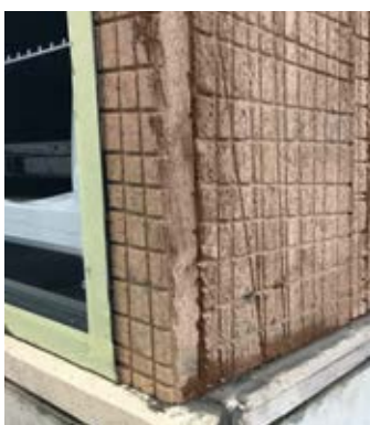
Rivestimento con refrattario
