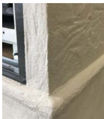
Fertigstellung mit Edelputz
