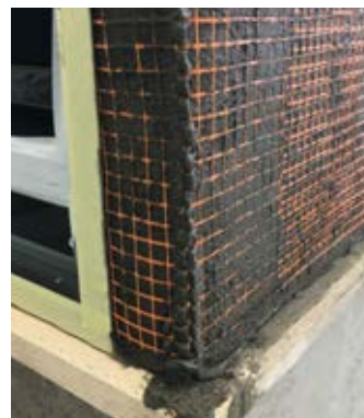
Application de renfort et de treillis anti-fissuration
